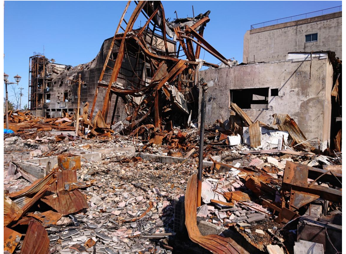
熱変形を受け崩れた鉄骨構造のビル3月22日撮影)
