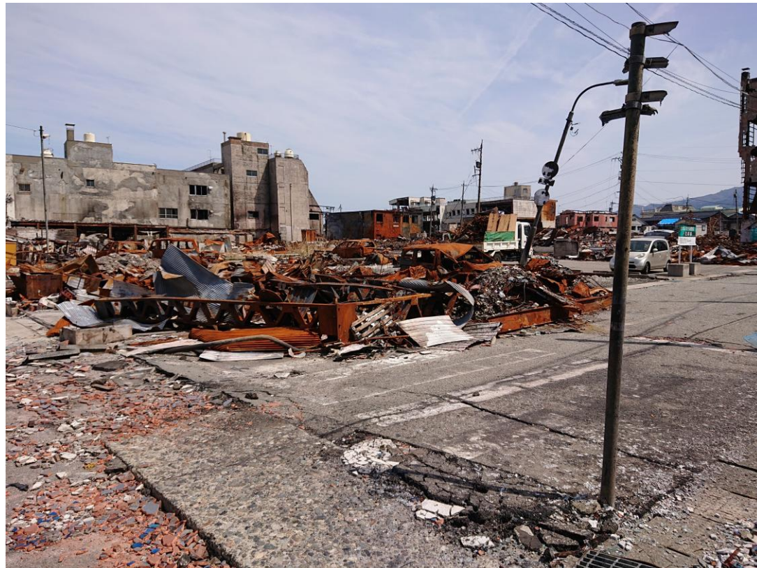
火元とされた建物近くの焼失地（4月6日撮影）
