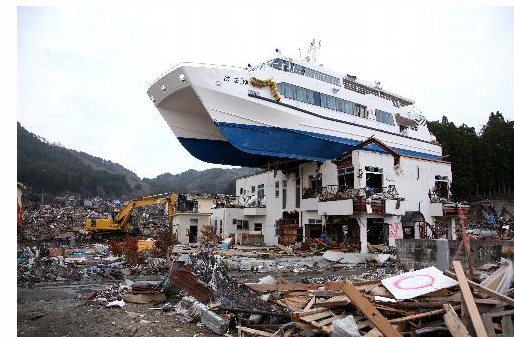
東北地方太平洋沖地震に おける津波漂流物
