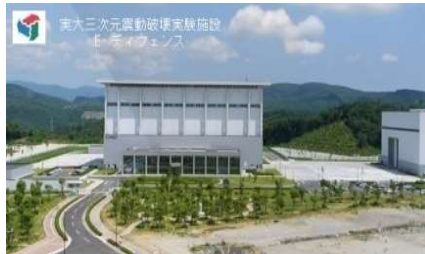
実大三次元振動破壊実験施設
