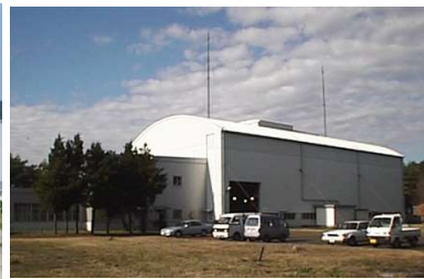
大型耐震実験施設
