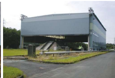
大型降雨実験施設
