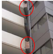
破損したExp.J部をベニヤ板で補修
