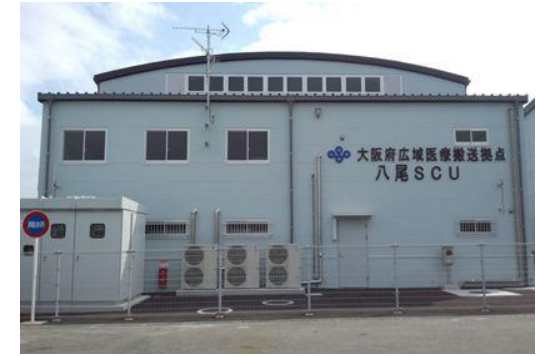
空港搬送拠点
