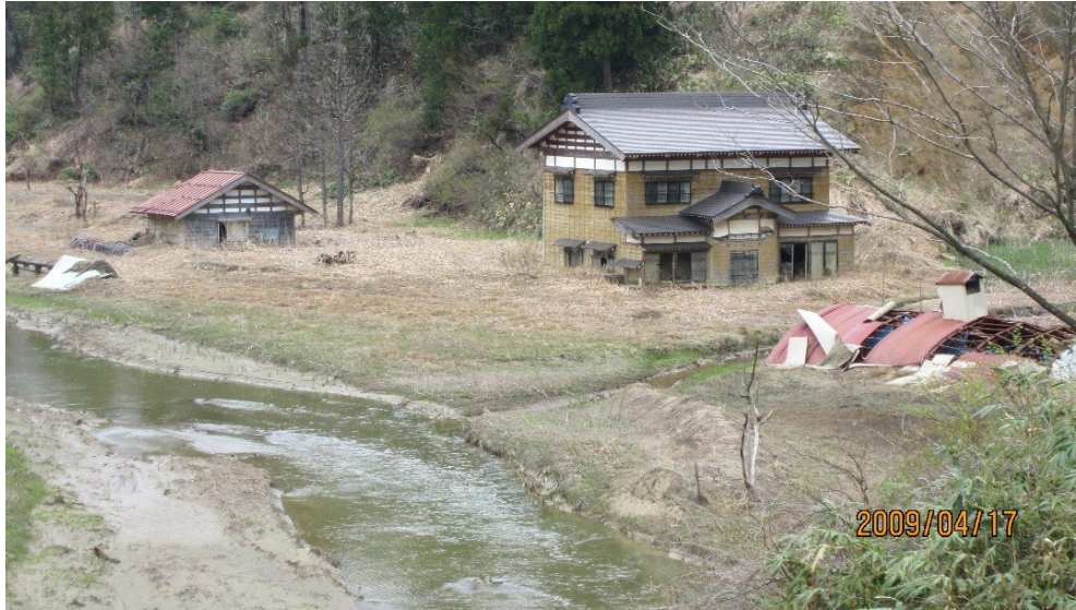
河道閉塞で水没した家屋が残る
